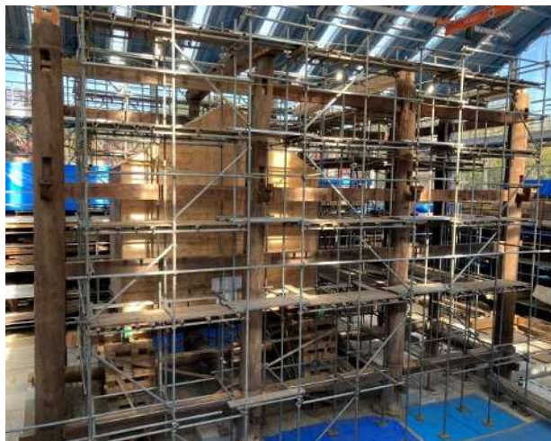
願興寺本堂解体修理の様子 2022. 11
